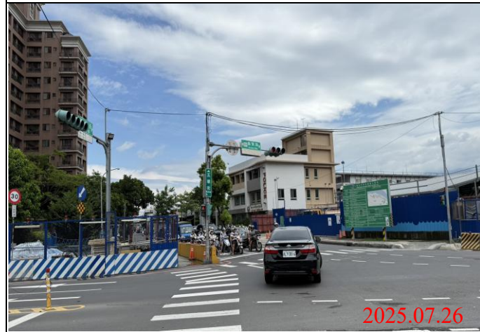
巡查日期地點：114.07.26/ Y22車站 照片說明：牌面設置狀況
