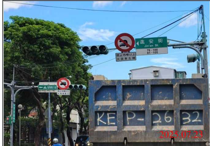
巡查日期地點：114.07.23/ Y23車站 照片說明：牌面設置狀況
