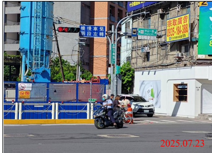
巡查日期地點：114.07.23/ Y21車站 照片說明：牌面設置狀況
