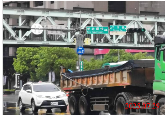
巡查日期地點：114.07.29/ Y23車站 照片說明：牌面設置狀況
