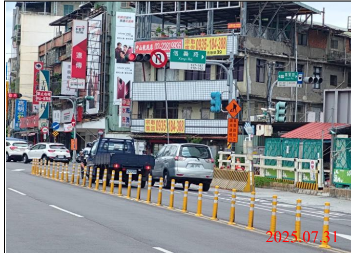
巡查日期地點：114.07.31/ Y21車站 照片說明：牌面設置狀況
