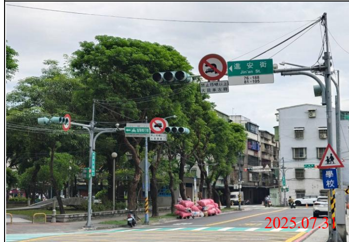
巡查日期地點：114.07.31/ Y23車站 照片說明：牌面設置狀況
