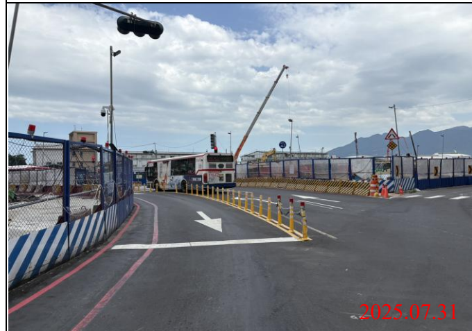
巡查日期地點：114.07.31/ Y22車站 照片說明：牌面設置狀況
