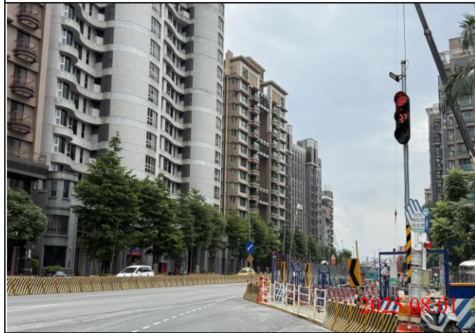
巡查日期地點：114.08.01/ Y23車站 照片說明：牌面設置狀況
