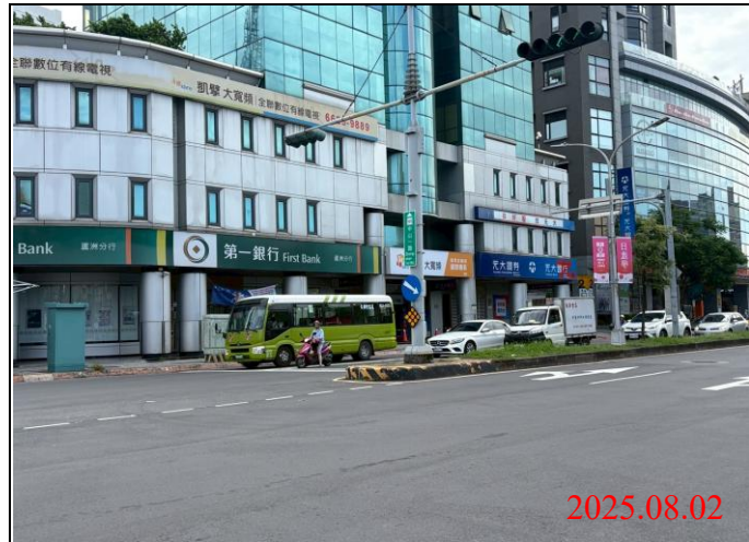
巡查日期地點：114.08.02/ Y21車站 照片說明：牌面設置狀況
