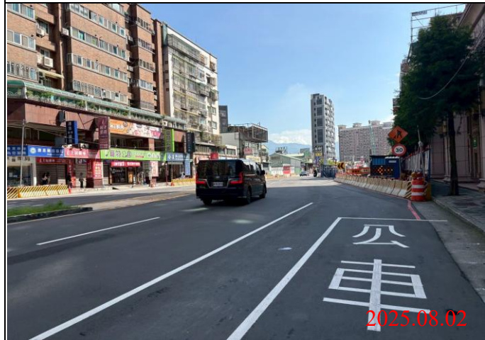
巡查日期地點：114.08.02/ Y22車站 照片說明：牌面設置狀況
