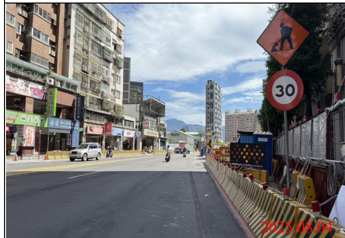
巡查日期地點：114.08.04/ Y22車站 照片說明：牌面設置狀況
