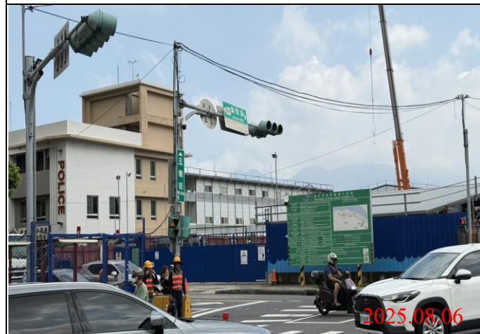
巡查日期地點：114.08.06/ Y22車站 照片說明：牌面設置狀況
