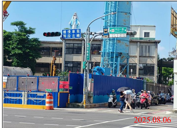
巡查日期地點：114.08.06/ Y21車站 照片說明：牌面設置狀況
