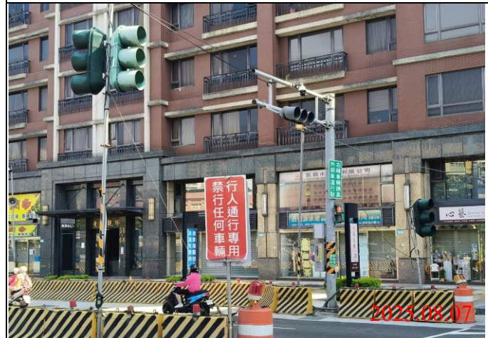
巡查日期地點：114.08.07/ Y23車站 照片說明：牌面設置狀況
