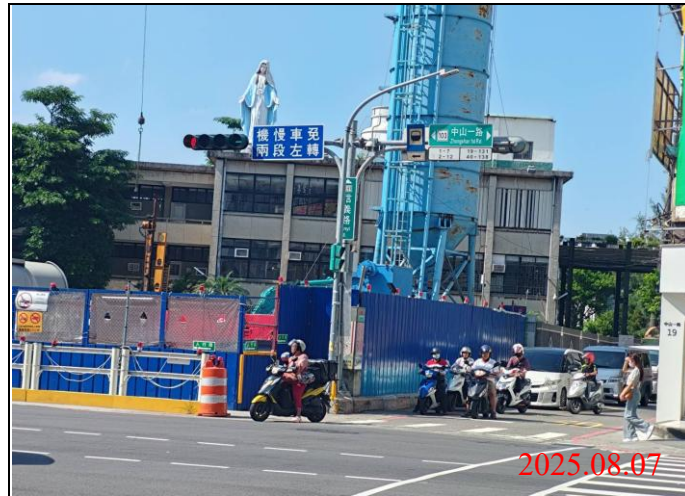
巡查日期地點：114.08.07/ Y21車站 照片說明：牌面設置狀況
