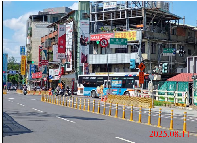
巡查日期地點：114.08.11/ Y21車站 照片說明：牌面設置狀況
