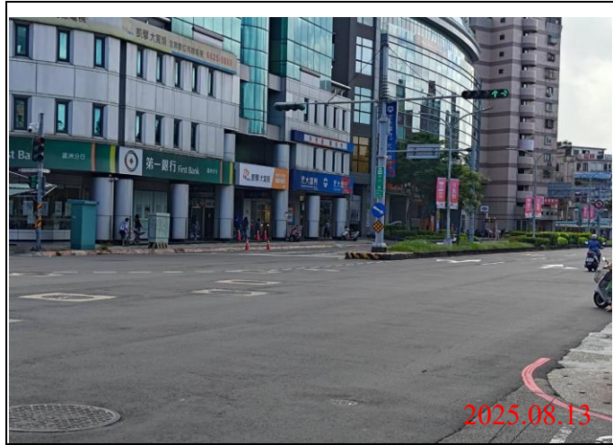
巡查日期地點：114.08.13/ Y21車站 照片說明：牌面設置狀況
