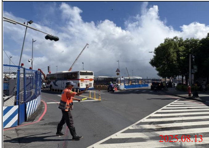
巡查日期地點：114.08.13/ Y22車站 照片說明：牌面設置狀況
