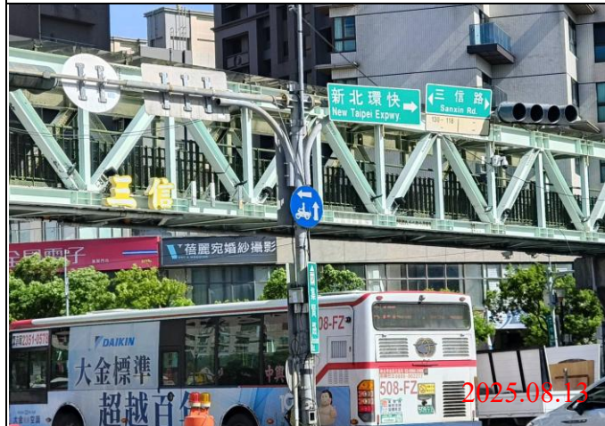
巡查日期地點：114.08.13/ Y23車站 照片說明：牌面設置狀況
