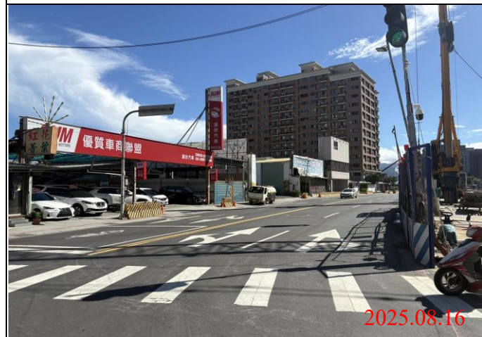
巡查日期地點：114.08.16/ Y22車站 照片說明：牌面設置狀況
