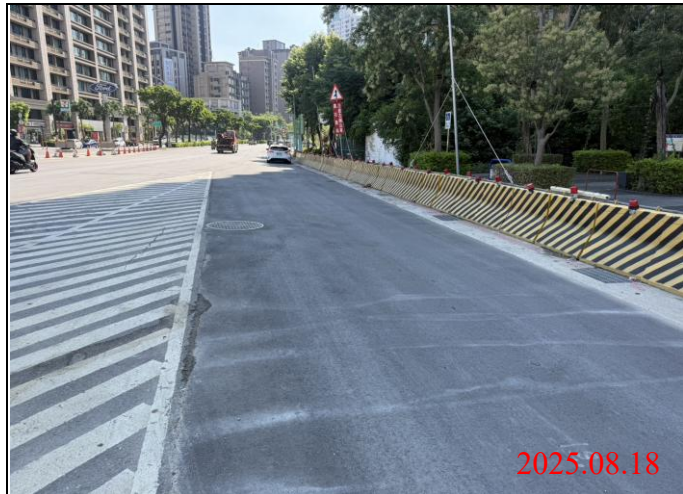
巡查日期地點：114.08.18/ Y22車站 照片說明：路面狀況
