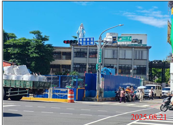
巡查日期地點：114.08.21/Y21車站 照片說明：牌面設置狀況
