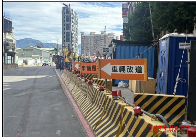
巡查日期地點：114.08.27/ Y22車站 照片說明：牌面設置狀況
