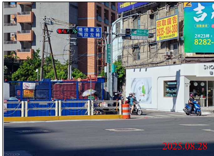
巡查日期地點：114.08.28/Y21車站 照片說明：牌面設置狀況
