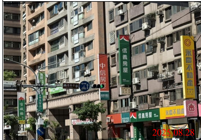
巡查日期地點：114.08.28/ Y22車站 照片說明：牌面設置狀況
