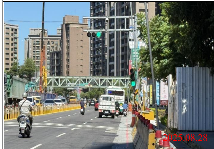
巡查日期地點：114.08.28/ Y23車站 照片說明：牌面設置狀況
