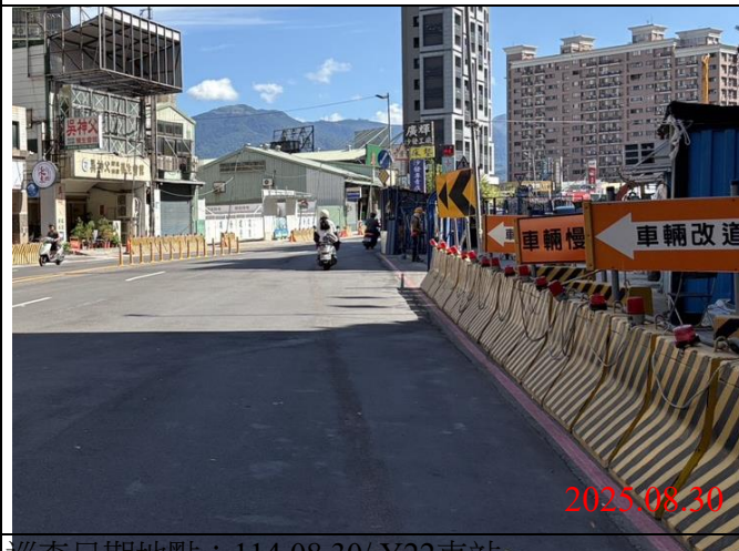
巡查日期地點：114.08.30/ Y22車站 照片說明：牌面設置狀況
