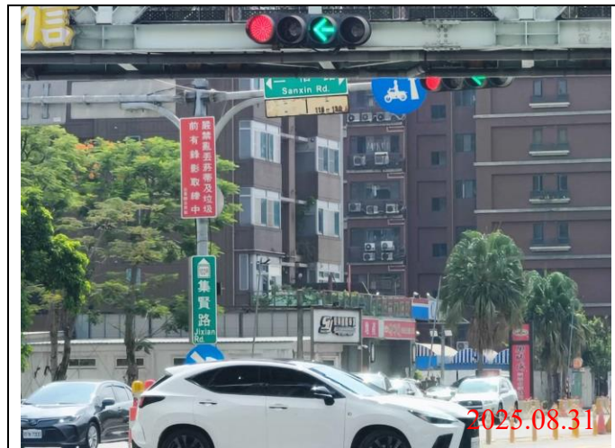
巡查日期地點：114.08.31/Y21車站 照片說明：牌面設置狀況
