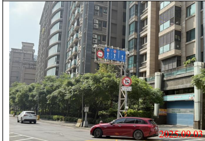
巡查日期地點：114.09.03/ Y23車站 照片說明：牌面設置狀況
