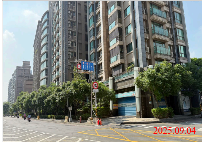
巡查日期地點：114.09.04/ Y23車站 照片說明：牌面設置狀況
