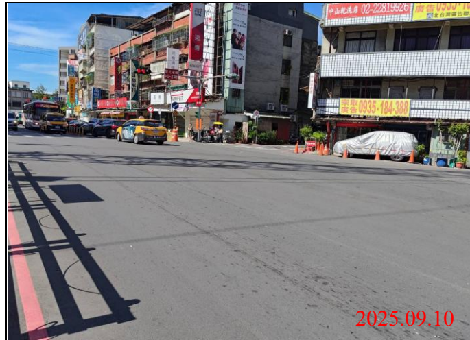
巡查日期地點：114.09.10/Y21車站 照片說明：牌面設置狀況
