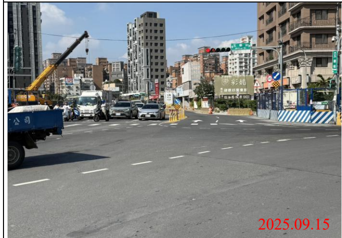
巡查日期地點：114.09.15/ Y22車站 照片說明：牌面設置狀況
