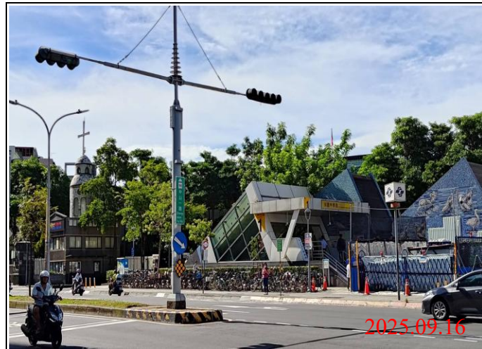
巡查日期地點：114.09.16/Y21車站 照片說明：牌面設置狀況
