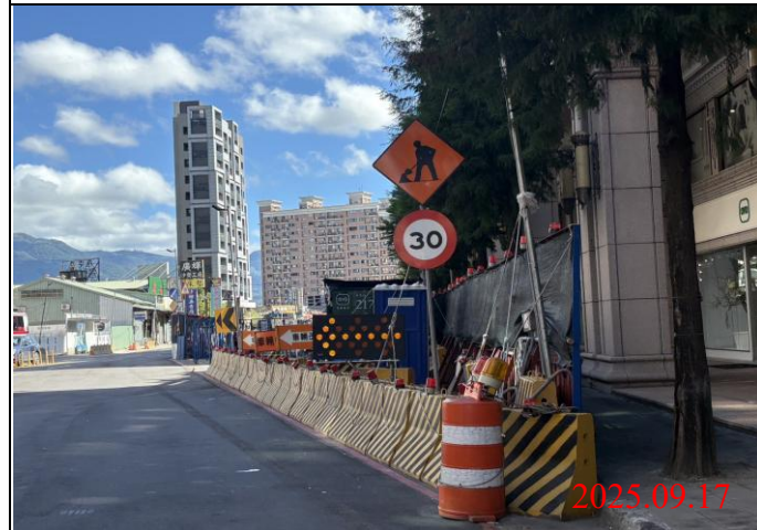
巡查日期地點：114.09.17/ Y22車站 照片說明：牌面設置狀況
