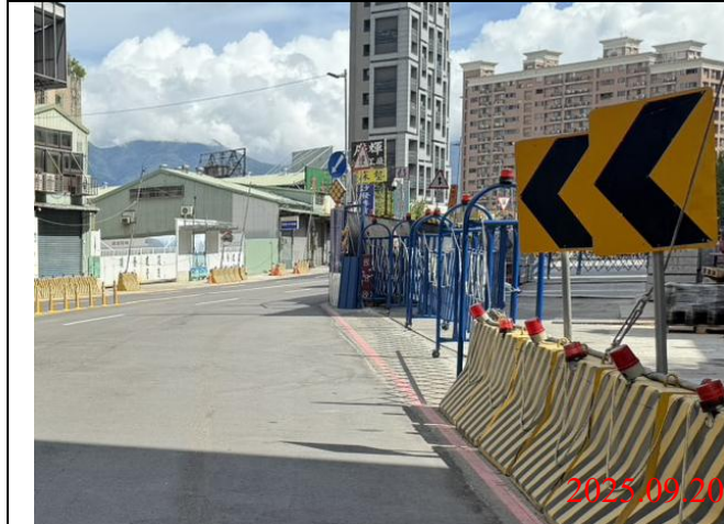
巡查日期地點：114.09.21/ Y22車站 照片說明：牌面設置狀況
