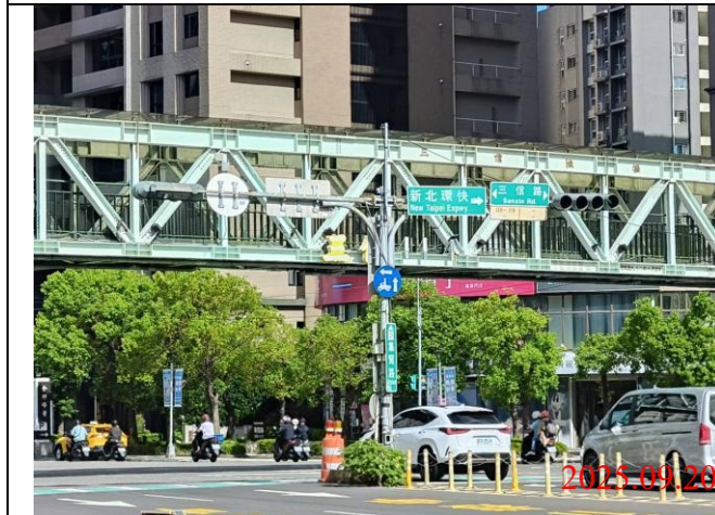
巡查日期地點：114.09.21/ Y23車站 照片說明：牌面設置狀況
