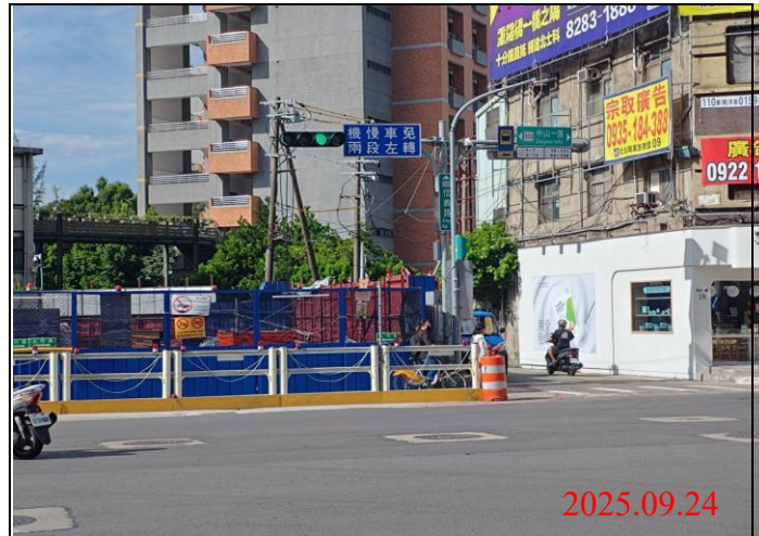
巡查日期地點：114.09.24/Y21車站 照片說明：牌面設置狀況
