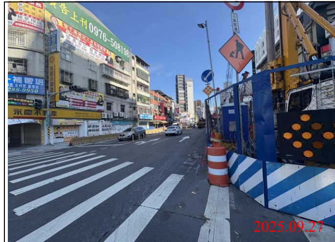
巡查日期地點：114.09.27/Y21車站 照片說明：牌面設置狀況
