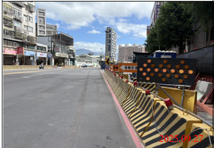
巡查日期地點：114.09.27/ Y22車站 照片說明：牌面設置狀況
