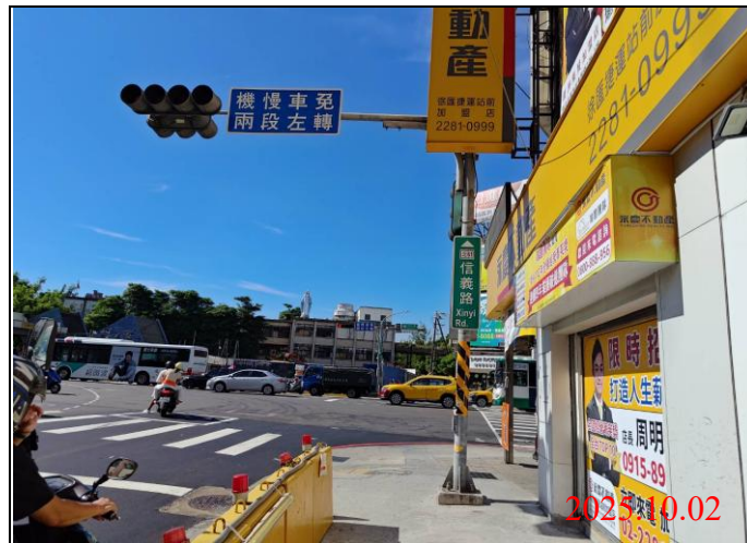
巡查日期地點：114.10.02/Y21車站 照片說明：牌面設置狀況
