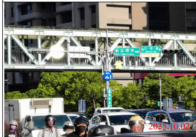
巡查日期地點：114.10.02/ Y23車站 照片說明：牌面設置狀況
