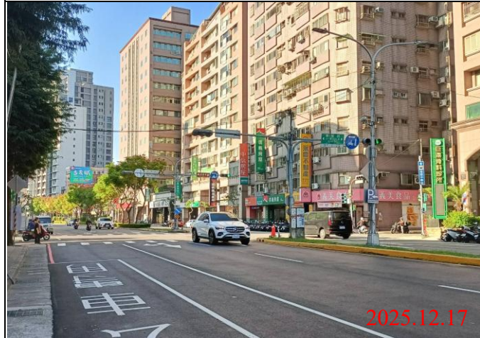
巡查日期地點：114.12.17/ Y22車站 照片說明：牌面設置狀況
