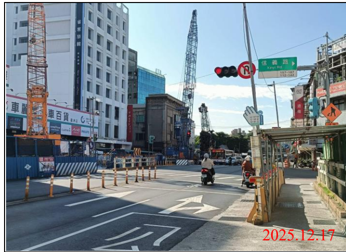
巡查日期地點：114.12.17/ Y21車站 照片說明：牌面設置狀況
