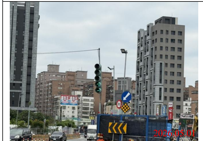
巡查日期地點：115.05.01/ Y22車站 照片說明：牌面設置狀況
