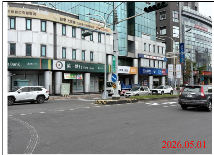
巡查日期地點：115.05.01/ Y21車站 照片說明：牌面設置狀況
