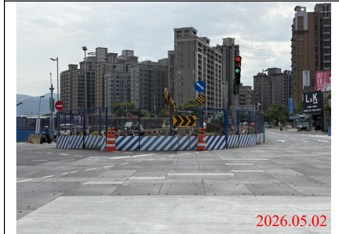
巡查日期地點：115.05.02/ Y22車站 照片說明：牌面設置狀況
