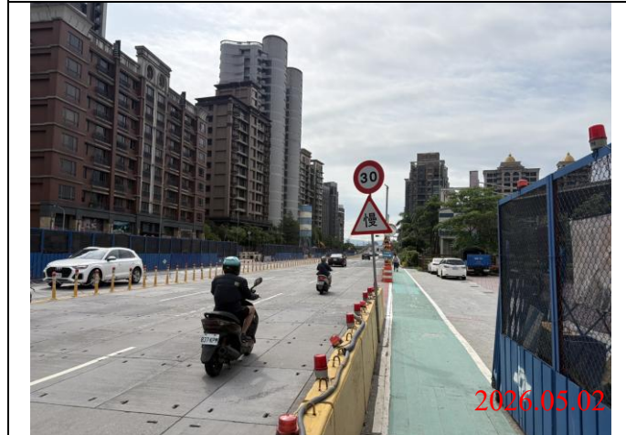
巡查日期地點：115.05.02/ Y23車站 照片說明：牌面設置狀況
