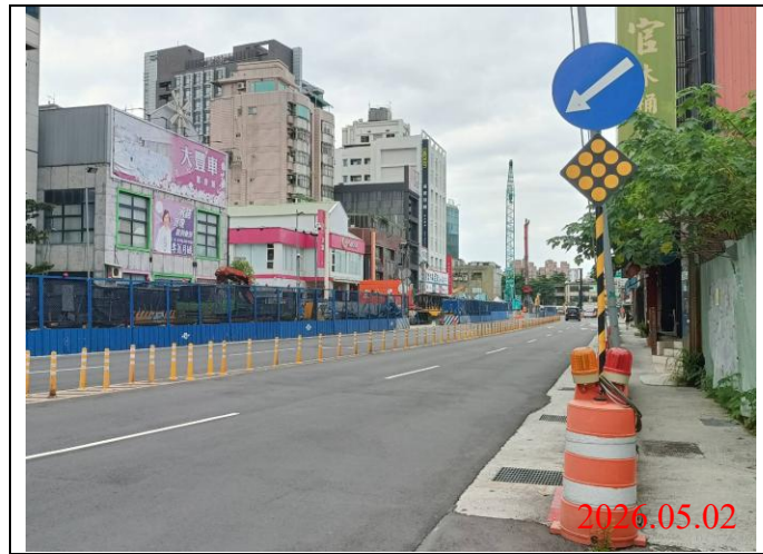
巡查日期地點：115.05.02/ Y21車站 照片說明：牌面設置狀況
