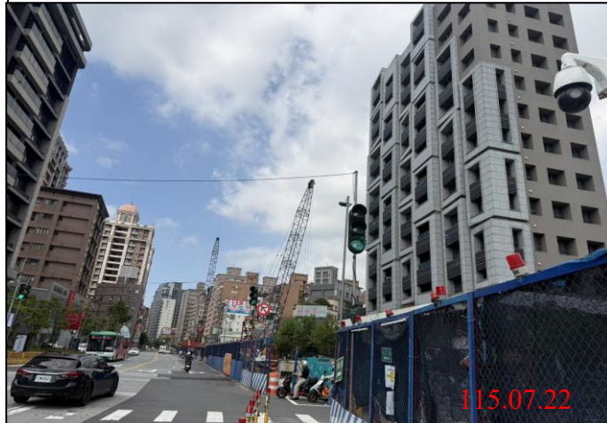
巡查日期地點：115.07.22/ Y22車站 照片說明：牌面設置狀況
