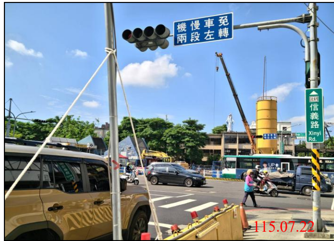
巡查日期地點：115.07.22/ Y21車站 照片說明：牌面設置狀況
