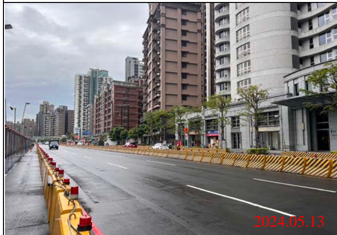
巡查日期地點：113.05.13/ Y23車站 照片說明：路面狀況
