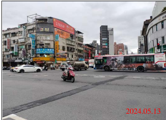
巡查日期地點：113.05.13/ Y21車站 照片說明：路面狀況
