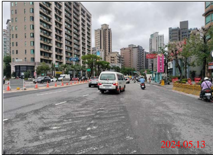
巡查日期地點：113.05.13/ Y22車站 照片說明：路面狀況
