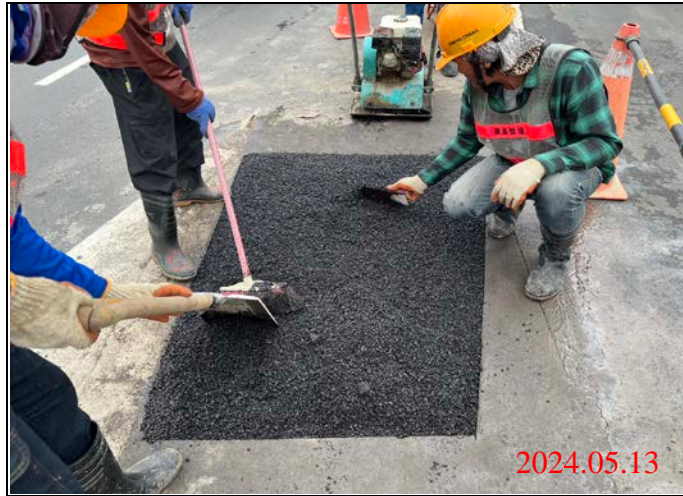
巡查日期地點：113.05.13/ Y22車站 照片說明：北側道路坑洞修補
